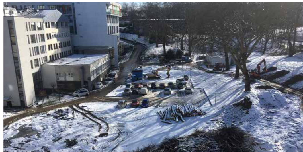
Trotz Schnee und Eis lief die Aufbereitung des Bau- feldes im Klinikpark weiter. Der Teich und einige Bäume mussten weichen.
