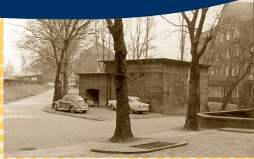
Der Wasserbunker versorgt die Klinik während des Krieges mit Trinkwasser.
