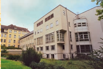
In diesem neuen Gebäude entstehen OP-Säle und eine moderne Radiologie.
