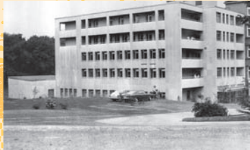
1971 wird ein Erweiterungsbau seiner Bestimmung übergeben: Der neue Betten- und Behandlungsstrakt hat 65 Krankenhausbetten.
